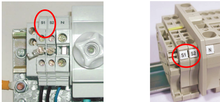
Fig. 5-2 .- Terminales de conexión del TC y Neutro en caso de ser necesario
