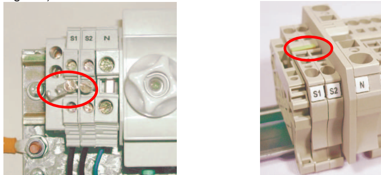
Fig. 5-5 .- Puentes para cortocircuitar el secundario del transformador de corriente (TC)
